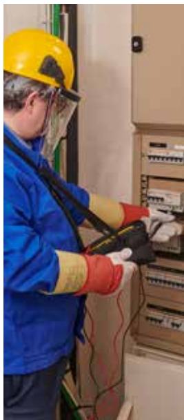
Kontrollmätning i elskåp
