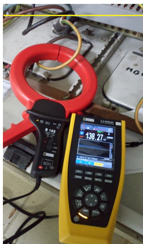
Mätning med läckströmstång. Strömstångens omsättning och storhet kan väljas i multimetern.
